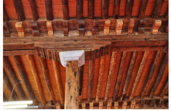
Şekil 2. Sivrihisar Ulucamii'nde Ahşap Kullanımı
