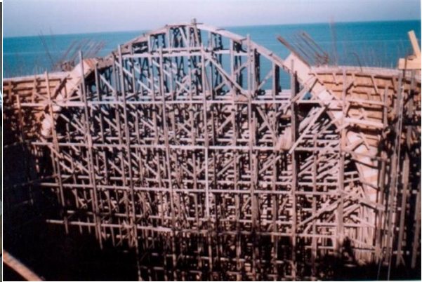
Fotoğraf 8: Kemerlerin İskele Kurularak Yapılması
