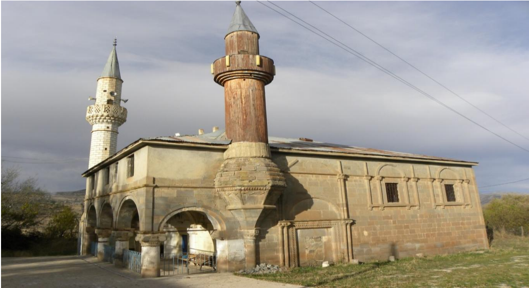
Resim - 1: Turpçu Köyü Camisinin (Kilise) genel görüntüsü
