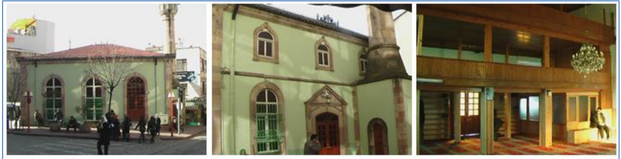
Şekil 19. Şeyh Keramet'in Camisi onarım öncesi fotoğrafları
