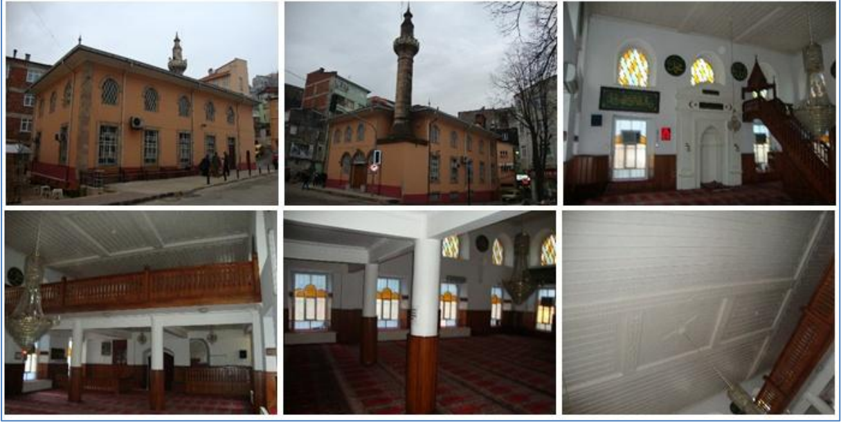
Şekil 33. Çınarlar Camii onarım öncesi fotoğrafları
