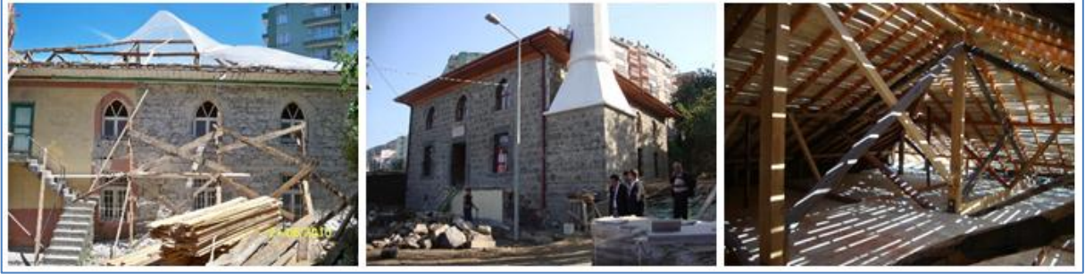
Şekil 9. Gemilerçekeği Camisi cephe ve çatı işleri fotoğrafları
