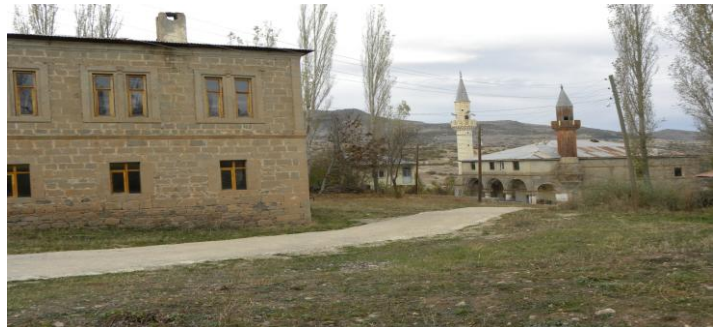
Resim - 20 : Turpçu Köyü Camisinin (Kilise) genel görüntüsü
