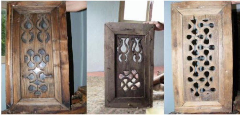
Şekil 16: Giresun Çaldağ Beldesi Melikli Mahallesi Tahtalı Camii Aplike Pencere Kanatları (Nefes, 2009).
