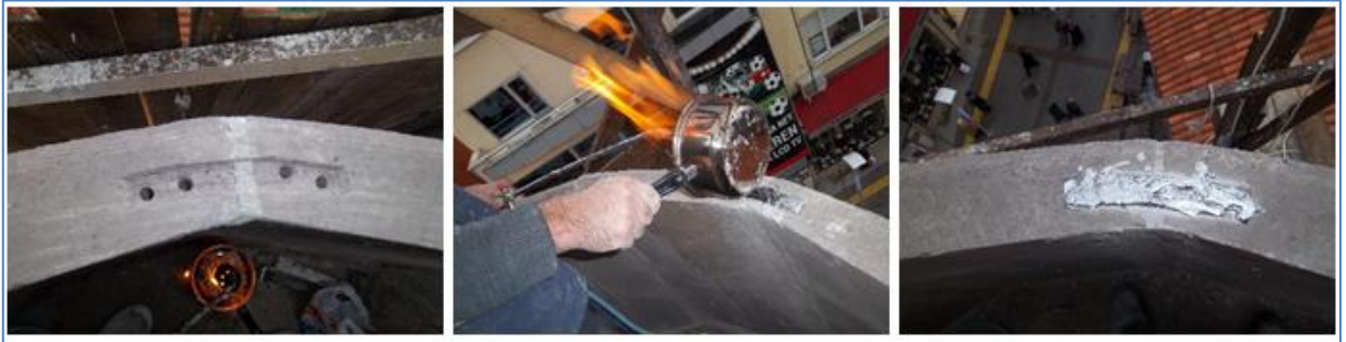
Şekil 24. Kurşun kenet yapılıması fotoğrafları
