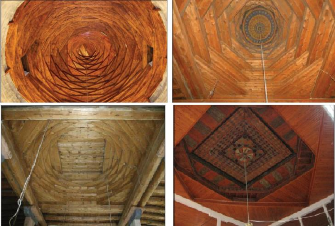
Şekil 9: Erzurum Ulu Camii, Bayburt Konursu Ulu Camii, Gümüşhane Özbeyli Köyü Camii ve Merzifon Hanife Hatun Camii Kırnangıç Tavanları (Atak, 2016:129-130).
