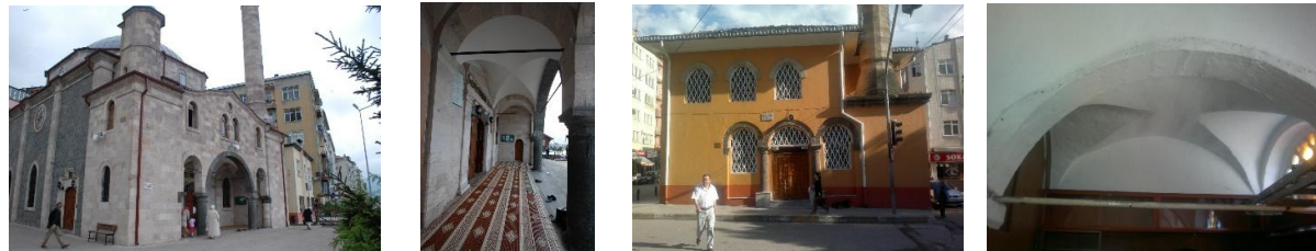
Giresun Merkez Hacı Mittad ve Çınarlar Camileri tonozlu son cemaat yerleri
