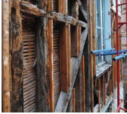
Şekil 3: Ertuğrul Tekke Camii Bağdadi Duvar Örneği (Yücel ve Koçak, 2010: 92).
