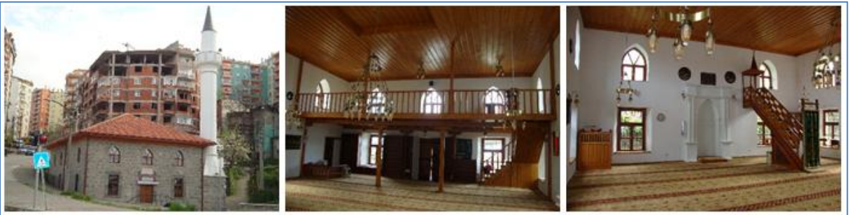
Şekil 8. Gemilerçekeği Camisi onarım sonrası fotoğrafları
