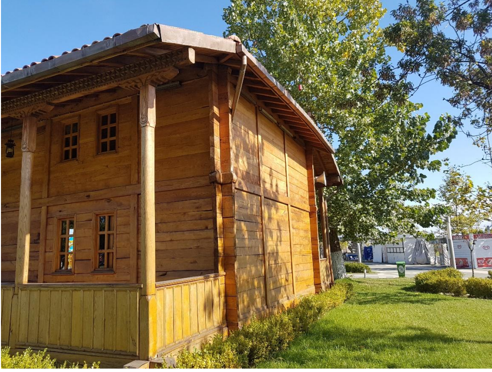
Resim 7- Ünye Sahil Camii'nin Güney Cephesi
