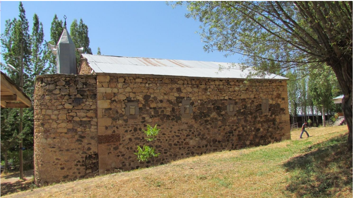
Resim-33 : Evcili Köyü Caminin (Kilise) kuzey cephesinden görüntü
