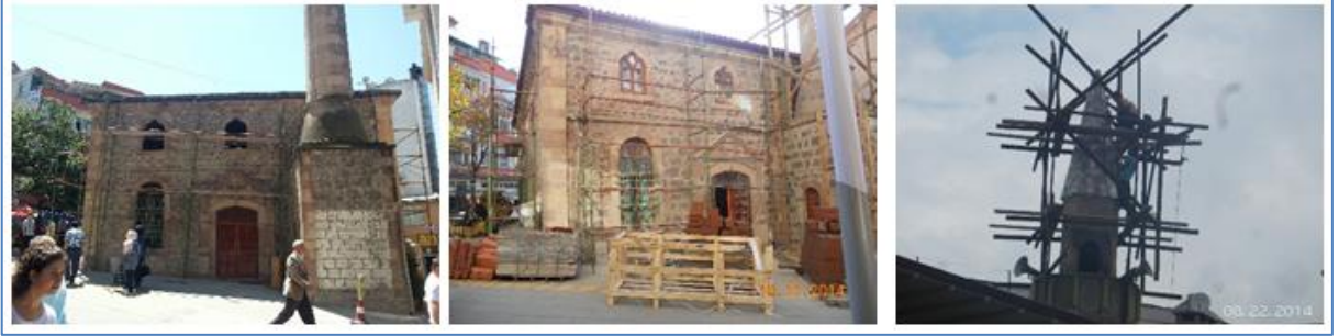
Şekil 23. Şeyh Keramettin Camisi cephe ve minare işleri fotoğrafları
