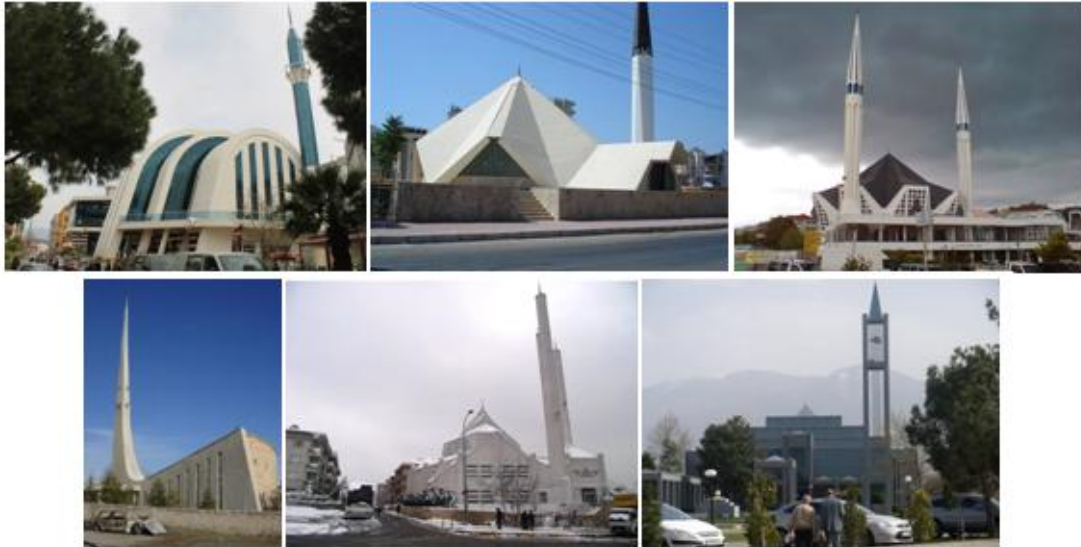
Fotoğraf 7. Üst Örtünün Kubbe Form Yerine Eğrisel (Gaziemir Sultan Yeni Cami, İzmir), Kırık/Eğimli Plak, (Hacı Mehmet Gebizli Cami Antalya, Akçakoca Merkez Cami Düzce), Kademeli/Piramidal (Medine Mescidi Cami İstanbul, TÜYAP Cami Bursa) Yorumlanan Örnekleri ( www.google.com.tr )
