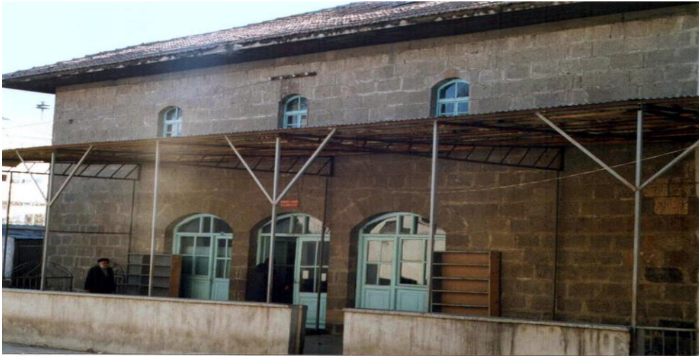
Resim-10: İğdir Merkez Cami Kuzey Cephesi
