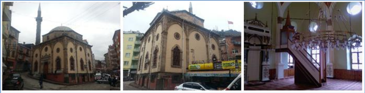
Şekil 26. Kapu Camisi onarım öncesi fotoğrafları
