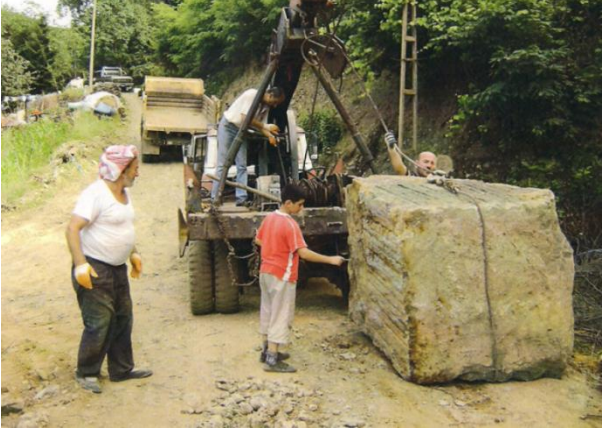
Fotoğraf 3: İnşaatta Kullanılan Taşın Nakli
