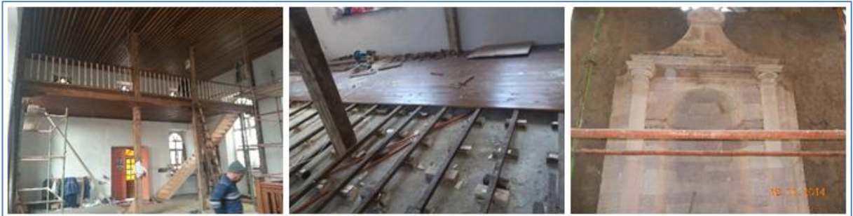
Şekil 22. Şeyh Keramettin Camisi onarım işleri fotoğrafları
