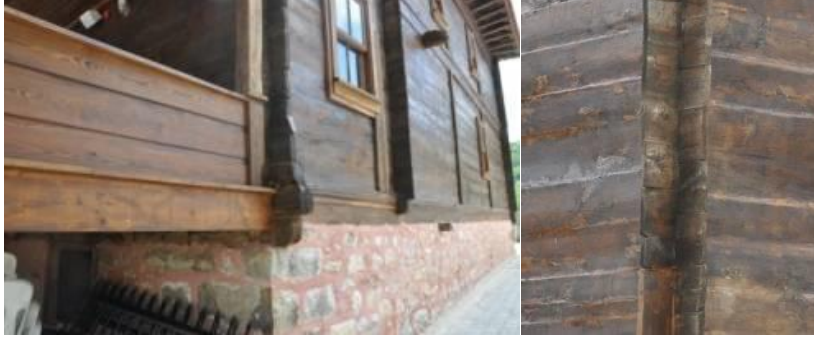
Şekil 2: İznik Elmalı Ahşap Camii Çantı Tekniği (Aydın ve Perker, 2015: 15).
