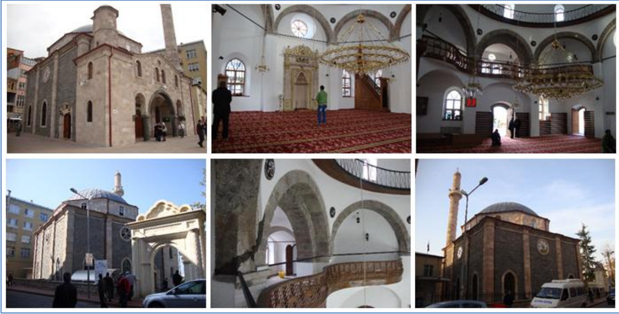
Şekil 14. Hacı Miktad Camisi onarım sonrası fotoğrafları
