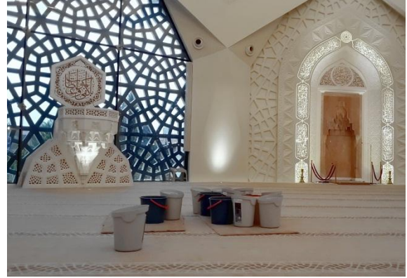
Fotoğraf-48 ve 49: Câmii Alt Kat Mihrabı ve Kubbeden Akan Yağmur Sularının Dolduğu Koyalardan Bazıları
