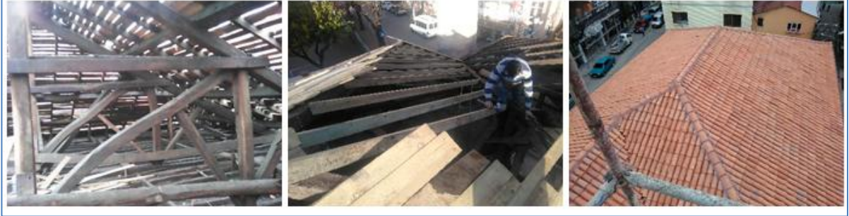
Şekil 35. Çınarlar Camisi çatı onarımı fotoğrafları
