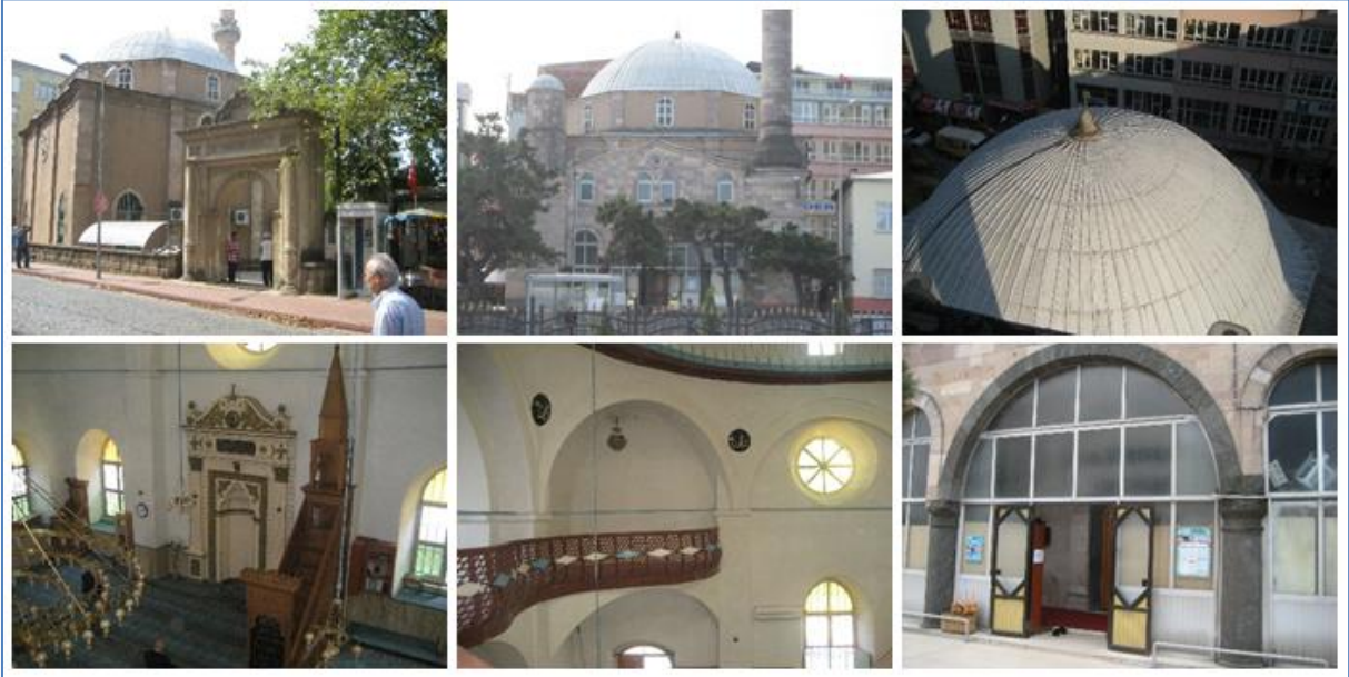
Şekil 13. Hacı Miktad Camisi onarım öncesi fotoğrafları
