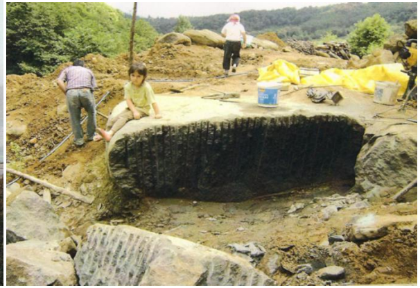
Fotoğraf 2: İnşaatta Kullanılan Taşın Çıkarılması
