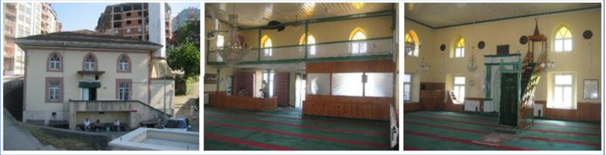
Şekil 7. Gemilerçekeği Camisi onarım öncesi fotoğrafları
