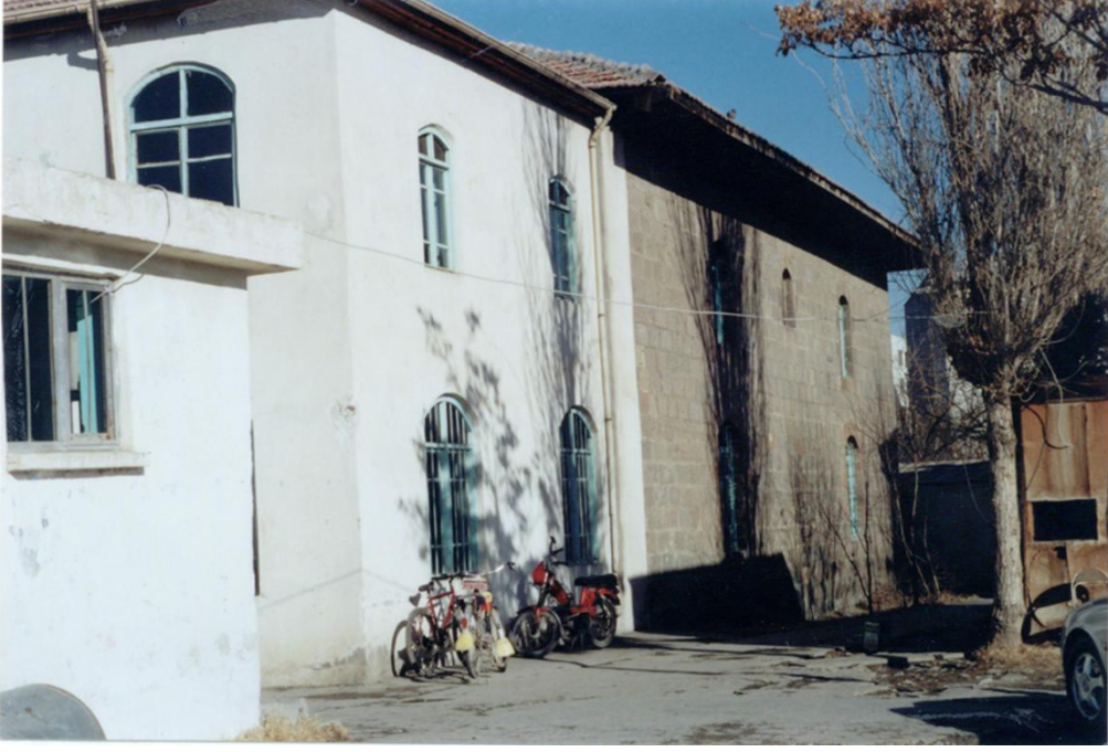
Resim-11: İğdir Merkez Cami Güneybatıdan Görünüm
